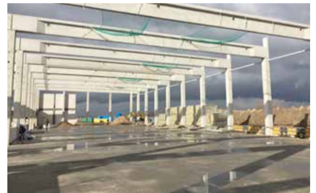
» Eine der Bauphasen
